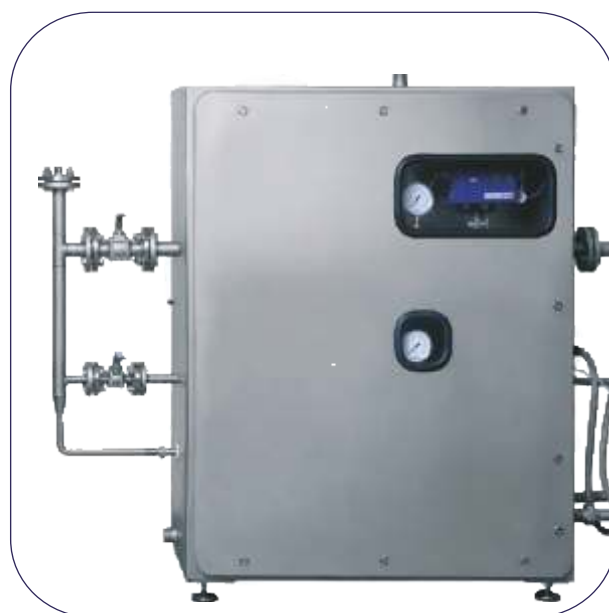
шкаф системы подогрева
